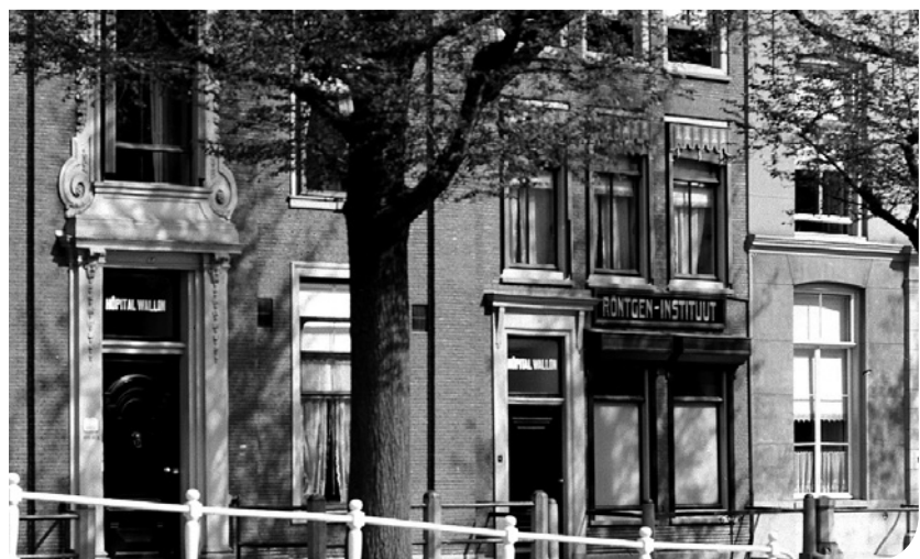
Figuur 5. Detail Hôpital Wallon rond 1910. Rechts het Röntgen Instituut op Rapenburg 14. Bron: Erfgoed Leiden en omstreken.
