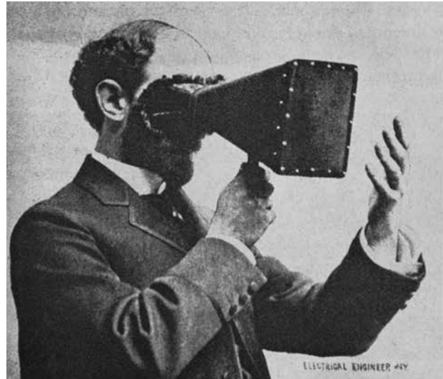
Figuur 8. Klassiek gebruik van de cryptoscoop op een foto uit maart 1896 waarop Daniel Webster Hering (1850-1938), wetenschapsauteur, laat zien hoe een onderzoeker de hardheid van de röntgenbuis test door z'n eigen hand te doorlichten.
