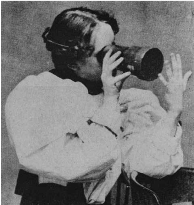
Figuur 3. Monoculaire cryptoscoop die ongeveer de vorm heeft zoals Salvioni die bedacht.
