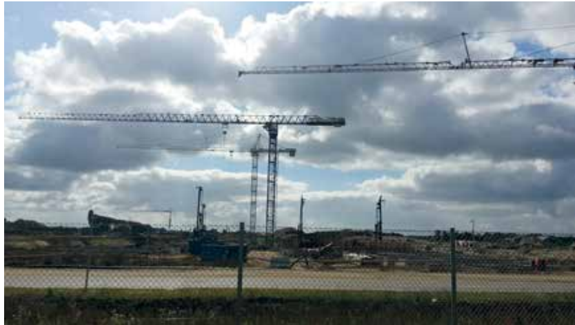
Nieuw regionaal ziekenhuis in aanbouw.
