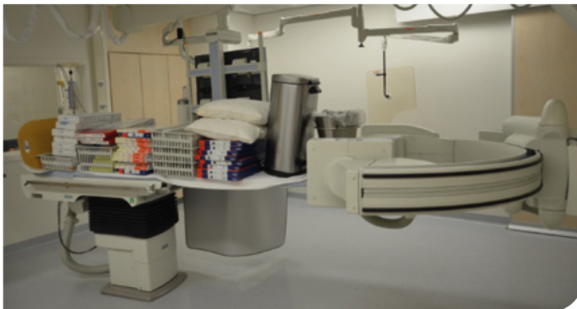
Alles moest van de vloer, ook de kabels.
